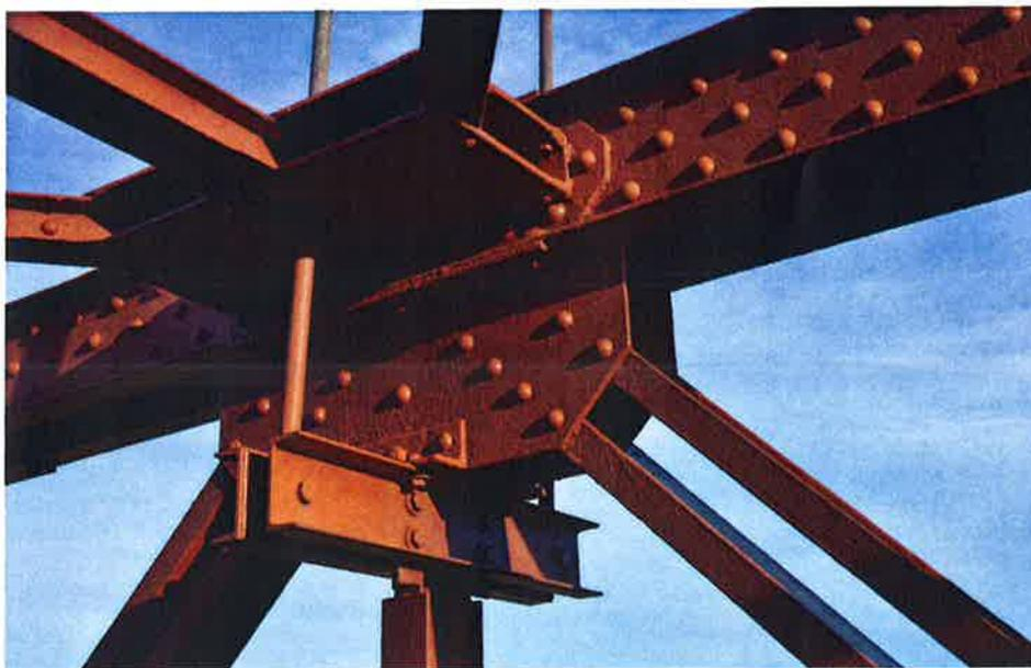
Detalle de los puntos de unión de la estructura del travesaño actual (Foto: Javier Vivanco Ruiz, 13-10-2018).
