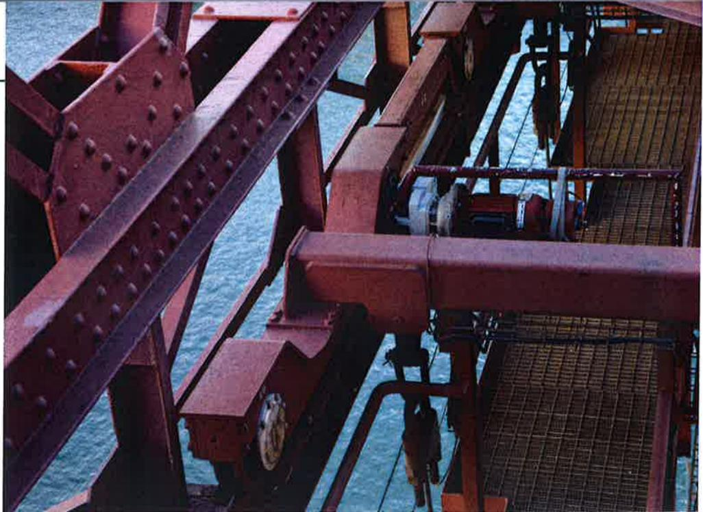
Extremo del carro automotor, lado mar. Se observan las ruedas, el bogie y el motor eléctrico. (Foto: Javier Vivanco Ruiz, 13-10-2018).
